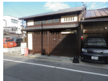
改修後の外観
