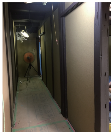
路地を廊下として利用(工事中)
