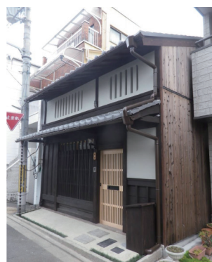
改修後、猪熊通りの外観
