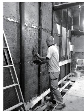
荒壁塗り：土に藁をまぜ寝かした荒壁を木舞に塗り、新しい壁の下地ができあがります。
