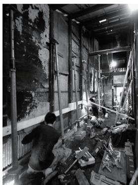
揚げ前(あげまえ)：基礎石を据え直し、各柱を持ち上げ、建物の水平レベルを補正します。
